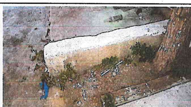
Foto 4: Implementacion de mueble de concreto
