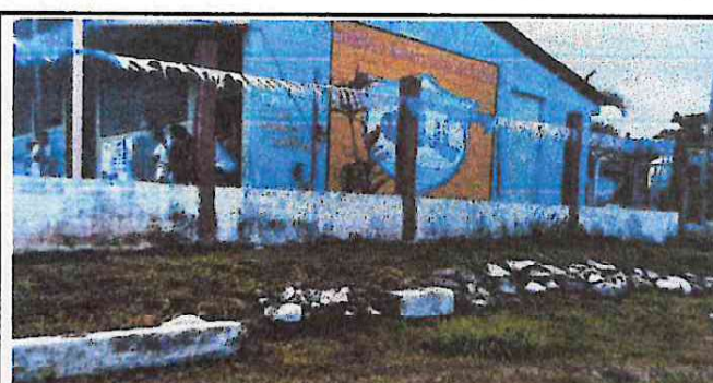
Foto 6: Reparación de banqueta de concreto
